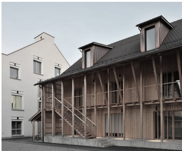
Satteldach und Laubengang Wohnsiedlung Orenberg, Ossigen
